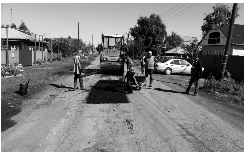
Ремонт дорог в р.п. Коченёво обошёлся в 32,7 млн рублей.
