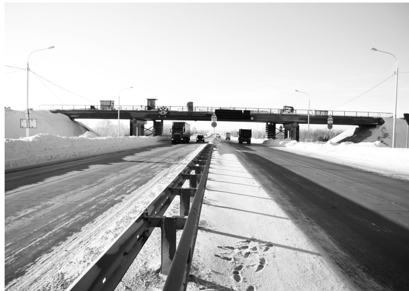
Участок федеральной трассы «Иртыш» после ремонта.
